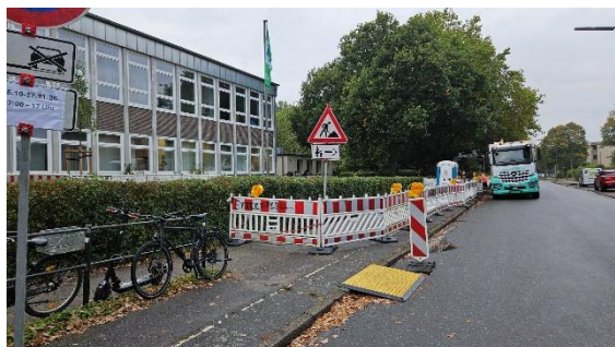
Temporär abgesperrter Bürgersteig vor der Schule
